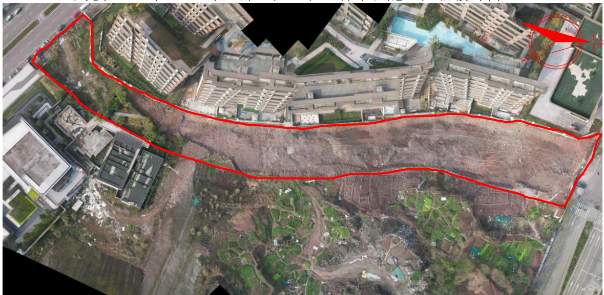
Ah20 路现状 （已于 2025 年 1 开工，正在进行路基施工，拍摄时间：2025.1）
