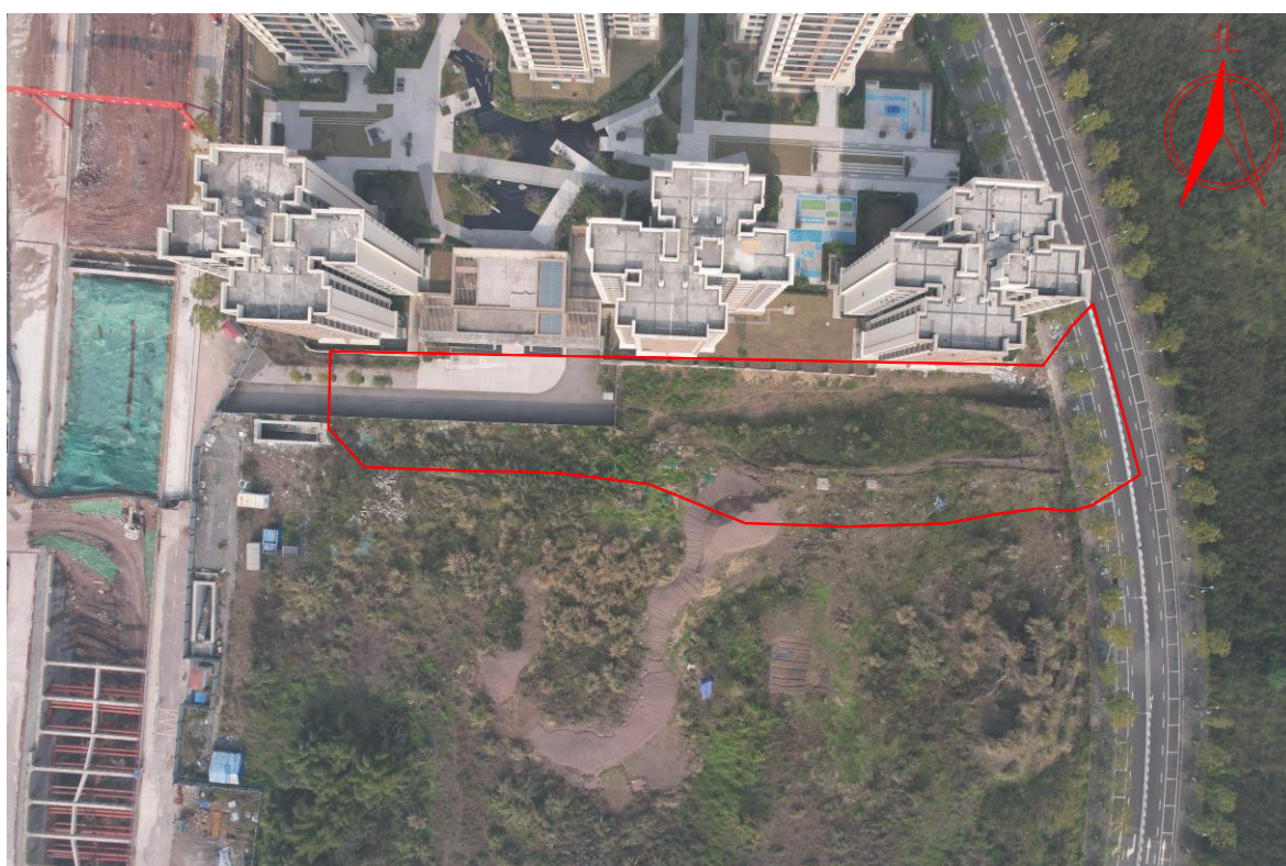
Ah03 路现状（未开工，拍摄时间：2025.1）
