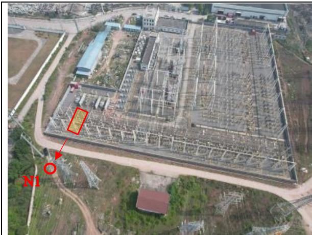
丰都 220kV 变电站及 N1 塔基位置
